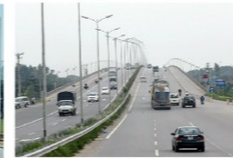
Dự án Cầu Thanh Trì Thanh Tri Bridge
