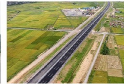
Dự án đường cao tốc Hà Nội – Hải Phòng Highway Hanoi – Haiphong
