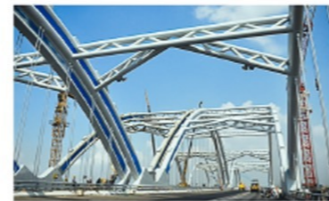
Ứng dụng làm cầu đường Applications do Bridges
